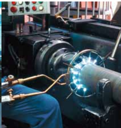
In speziellen Anwendungsfällen werden die Wellen nach dem Zusammenpressen, als Vorbereitung auf die Schweißnaht, vorgewärmt.
